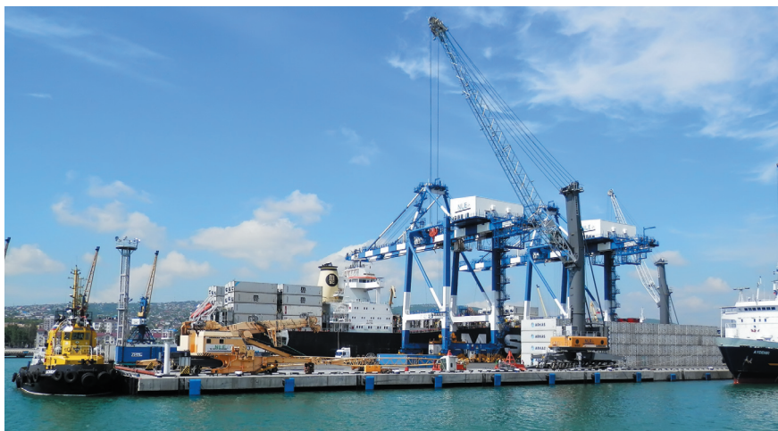
ПРИЧАЛ НЛЭ ПОСЛЕ РЕКОНСТРУКЦИИ. ФОТО «НОВОМОРНИИПРОЕКТ»
